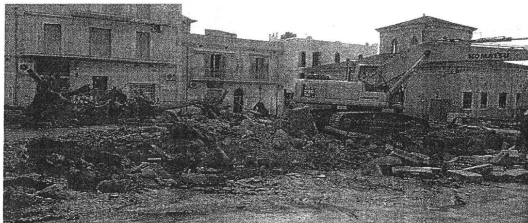
I lavori nella piazza di Marina di Ragusa
